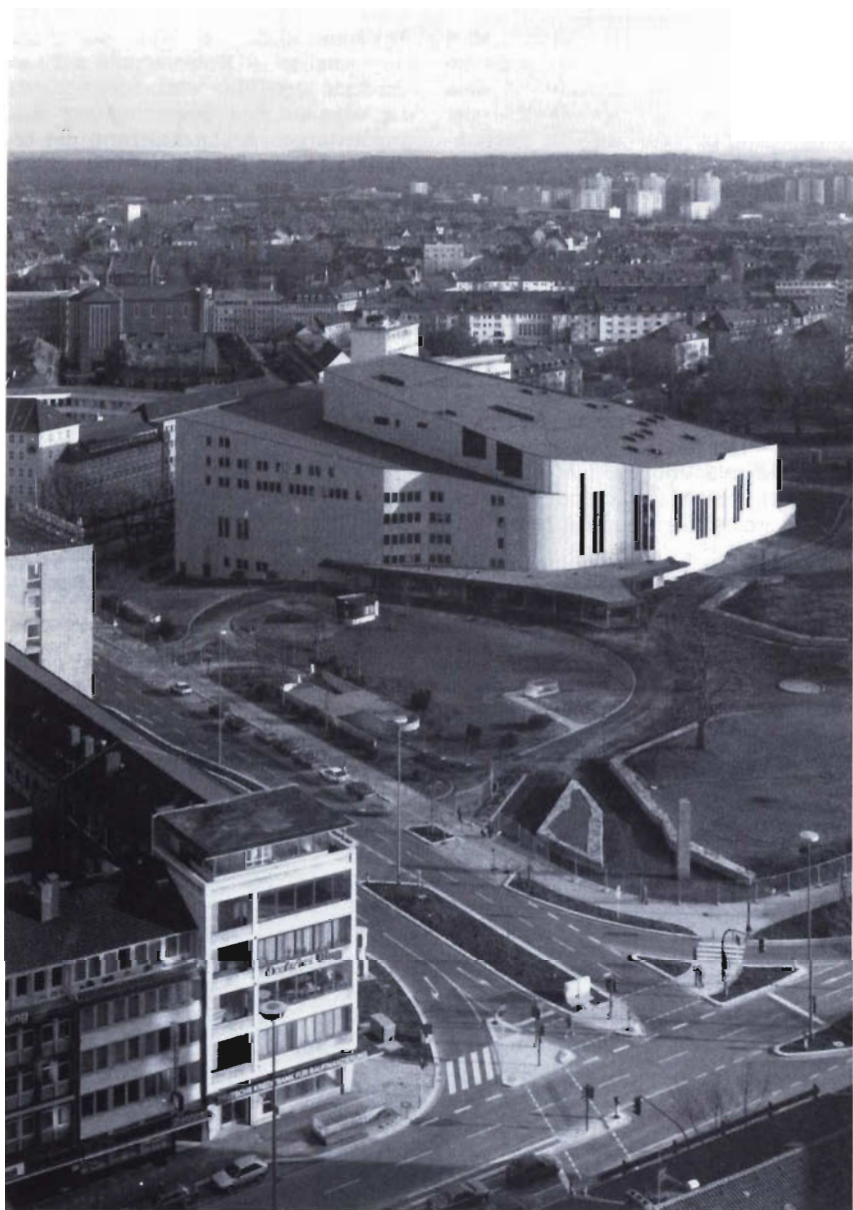
Ein städtebaulicher Akzent mit besonderer Note — Essens neues Theater am Stadtgarten im Südviertel, zwischen der City und Rüttenscheid, gelegen. Das Foto erlaubt einen Fernblick bis zu den Langenberger Sendern über die bewaldeten Ruhrhöhen hinweg. Rechts oben die Silhouette der Hochhäuser u. a. im Bereich der Müller-Breslau-Straße in Rüttenscheid.
