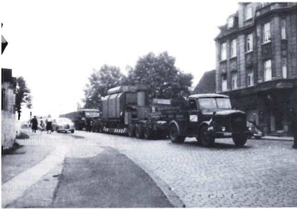
Transport des Transformators für die Stromversorgung in Rüttenscheid 1958 — hier im Bereich des Bahnhofs in Rüttenscheid/ Paulinenstraße.
