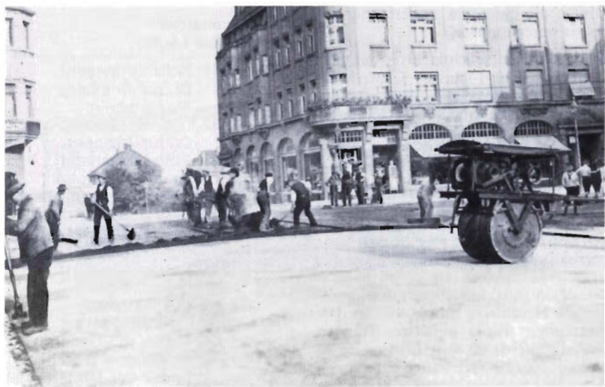
Baustelle 1923: Kreuzung Franziska-, Rüttenscheider- und Martinstraße/Ecke Wehmenkamp. Foto: H. Heckert, Essen
